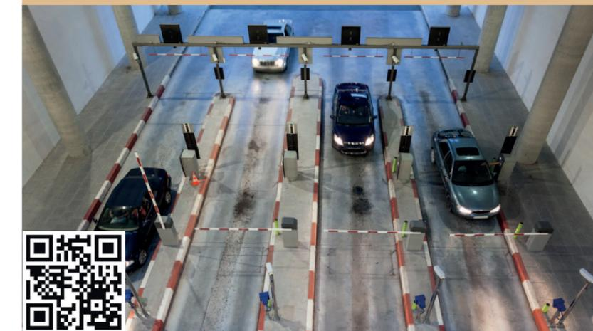
Mit der Kennzeichensuche kann der Benutzer Fahrzeuge an Ein- und Ausfahrtspunkten identifizieren, verfolgen und analysieren. Die Kennzeichen werden automatisch im Stop & Go-Verkehr oder im bewegten Verkehr zur späteren Überprüfung erfasst. Auch Zutrittssysteme zum Öffnen oder Schließen von Schranken lassen sich über C-WERK® steuern. Eine manuelle Steuerung durch Personen ist somit nicht erforderlich.
